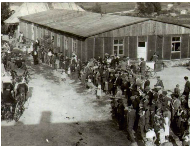
Ryc. 1. Budynek szkoły w Wielopolu Skrzyńskim przed tragicznym pożarem
