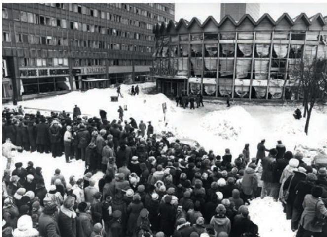
Ryc. 12. Widok od zewnątrz zniszczonego budynku Rotundy PKO Źródło: Wydział ds. działalności muzealnej KM PSP m.st. Warszawy.
