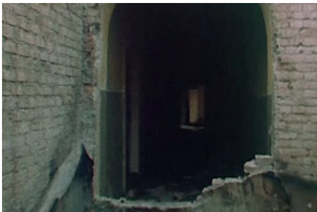
Ryc. 15. Widok pozostałości ścianki, którą zamurowano drzwi
